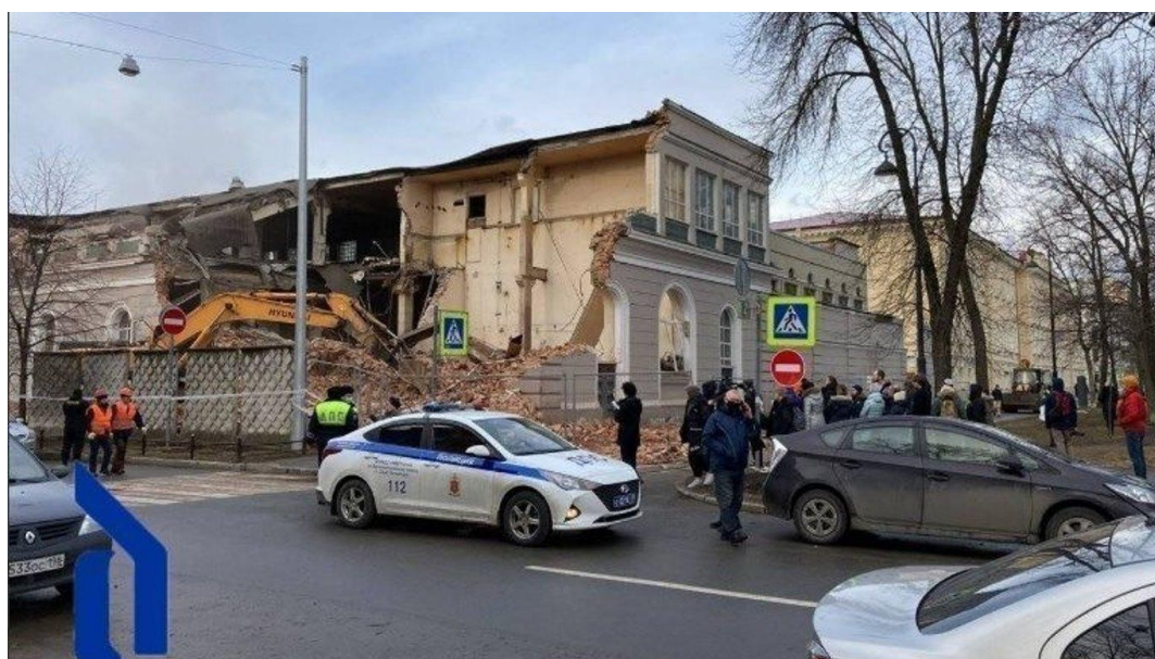
Рисунок 2. Разрушение здания лейб-гвардии Финляндского полка (апрель, 2022)
